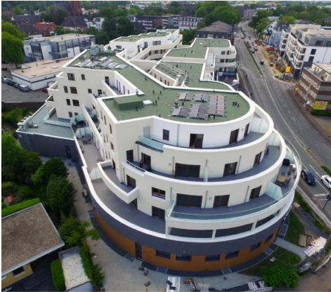
Aussenansicht Haus Rondo
